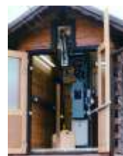
SEBA-Seilkrananlage mit elektrischer Doppelwinde SDW-ESM
