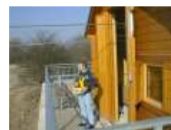
Steuerung mit Fernbedienung
