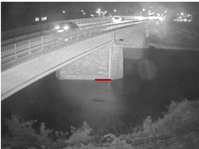
Nivel de agua detectado ópticamente en condiciones de visibilidad nocturna.
