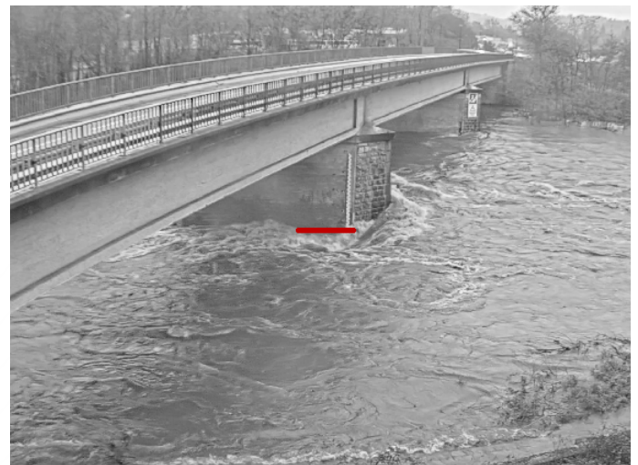
Nivel de agua detectado bajo la luz diurna, durante una inundación.
