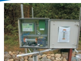
Installation dans l'armoire électrique
