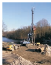
Sitio de construcción
