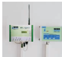
Instalación junto con el Powerbox
